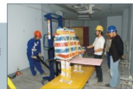
2006年11月10日 直线加速器设备进场安装
