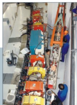
2007年11月9日至11月30日完成首批线站的前端区全部吊装
