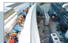
2007年5月完成储存环 C10单元集成试安装
