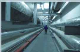
地下管线走廊
