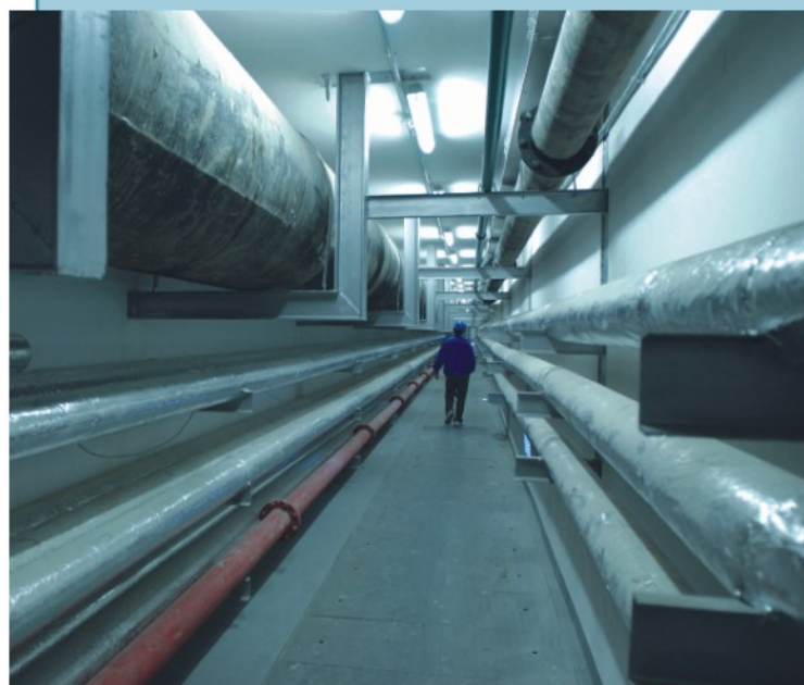
地下管线走廊
