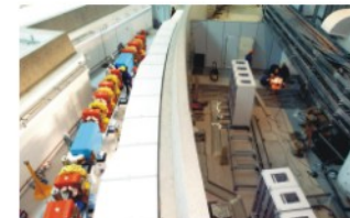
储存环C10单元集成试安装
