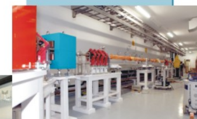
2007年3月完成 直线加速器设备安装
