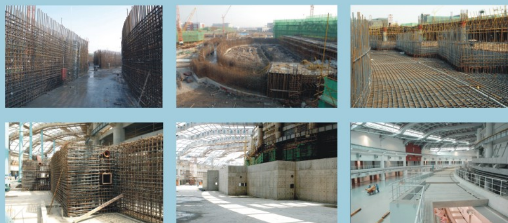
加速器隧道防护墙
