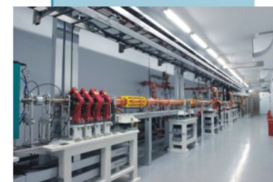
2006年11月10日 直线加速器设备进场安装
