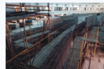
储存环隧道 闭环施工
