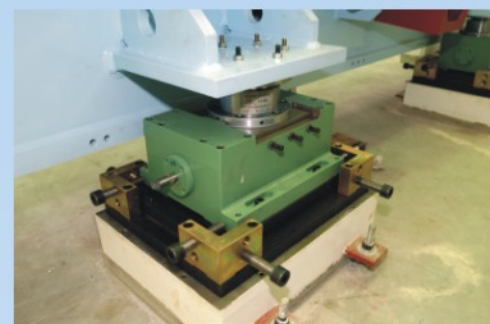
储存环单元试安装
