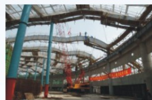
2006年4月28日 主体建筑钢结构吊装完成
