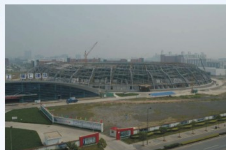
2006年4月28日 主体建筑钢结构吊装完成
