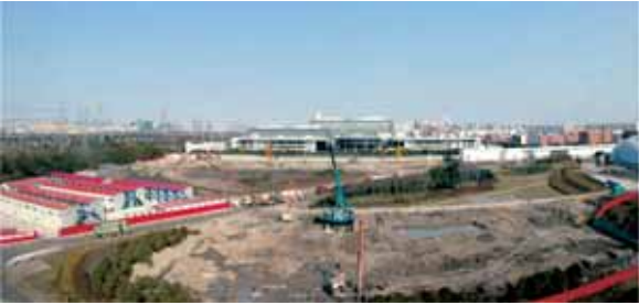
桩基施工现场
