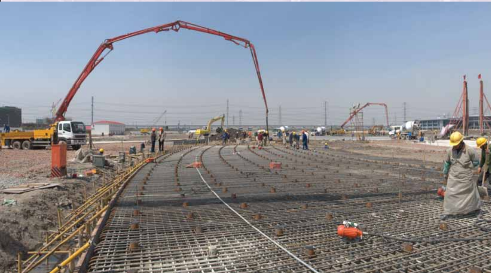
2004年12月25日，上海光源工程正式破土动工。
